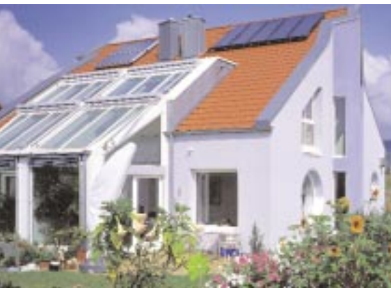
Sonnenwärme sammeln: Sonnenkollektoren auf der Südseite des Gebäudes.
